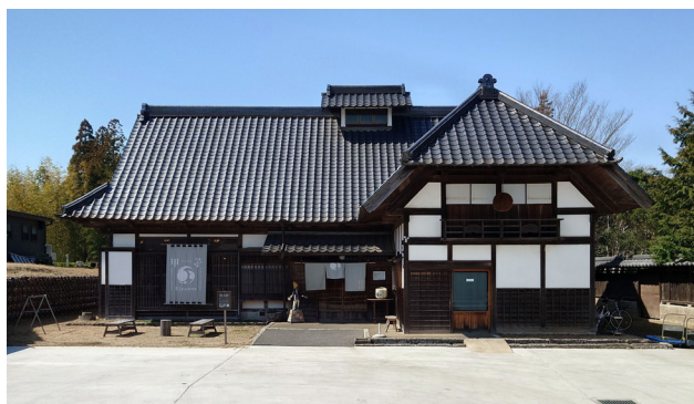
写真 1：きのえねまがり家は新潟県にあった肝煎り清野家の曲り家です。電源開発に伴い水没の危機にあったところを平成 6 年この地に移築再生したものです。
